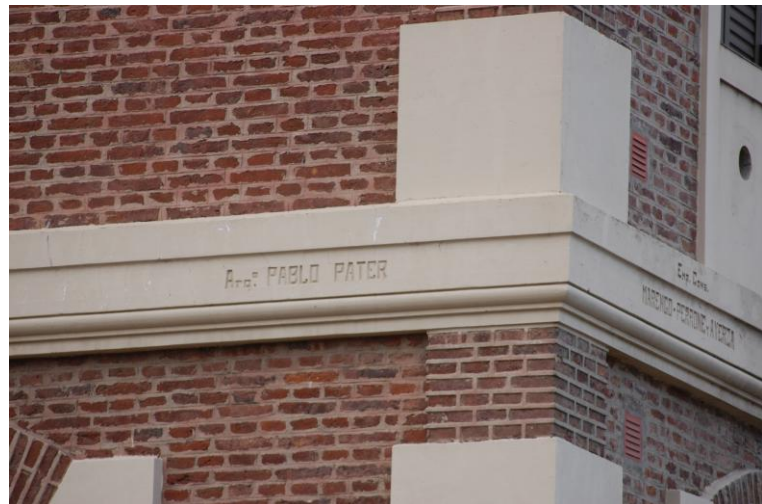
Barraca "Masurel Fils". Detalle de la esquina. Se puede apreciar el trabajo en ladrillo, las molduras y la inscripción con el nombre del profesional.
