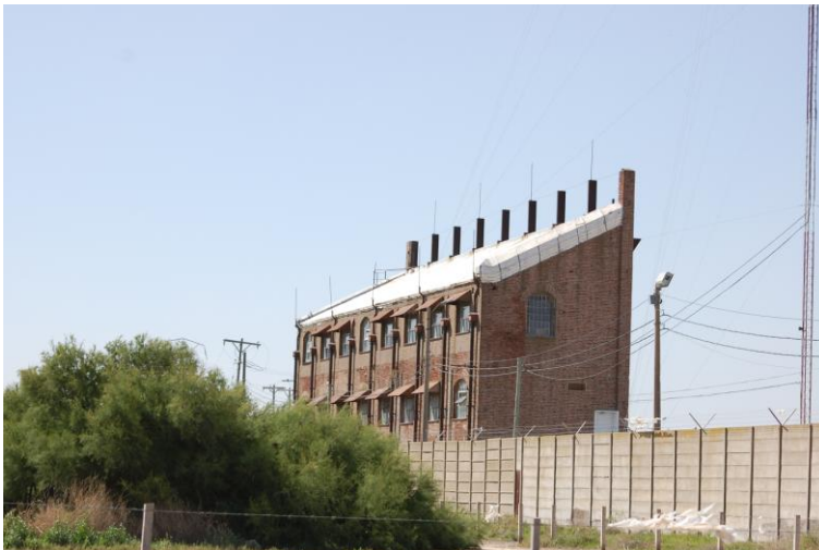
Vista de la construcción existente en la actualidad, sólo una parte del importante edificio que originalmente construyera la empresa BAP.
