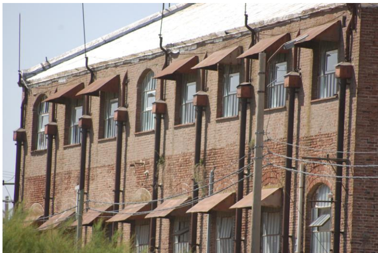
Usina Loma Paraguaya. Vista parcial de la fachada actual.
