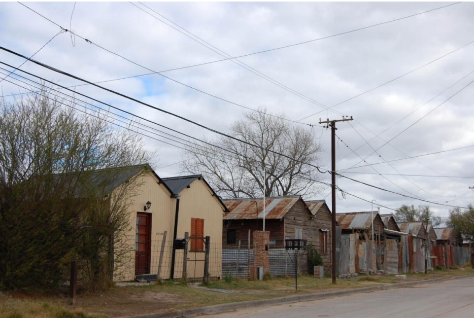
Conjunto de viviendas ferroviarias. Ingeniero White.
