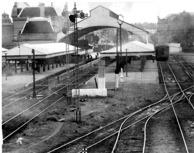
Vista hacia el andén cubierto.
