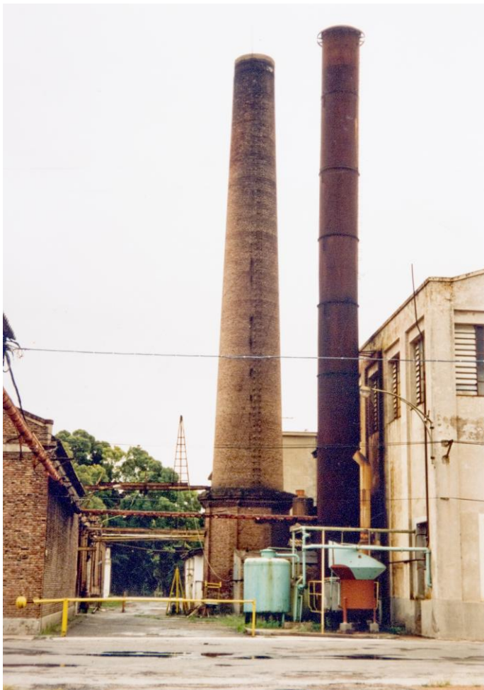
General Cerri. Frigorífico Cuatrerros. Chimenea.
