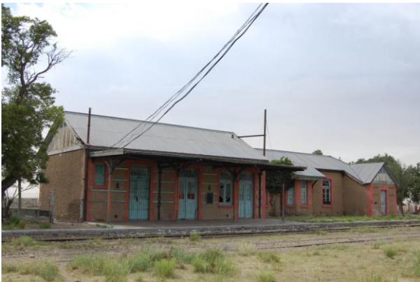
Fachada sobre el andén. Muros con revoques, andén semi-cubierto, aberturas de madera. Los techos parecen haber sido reemplazados en épocas bastante recientes.
