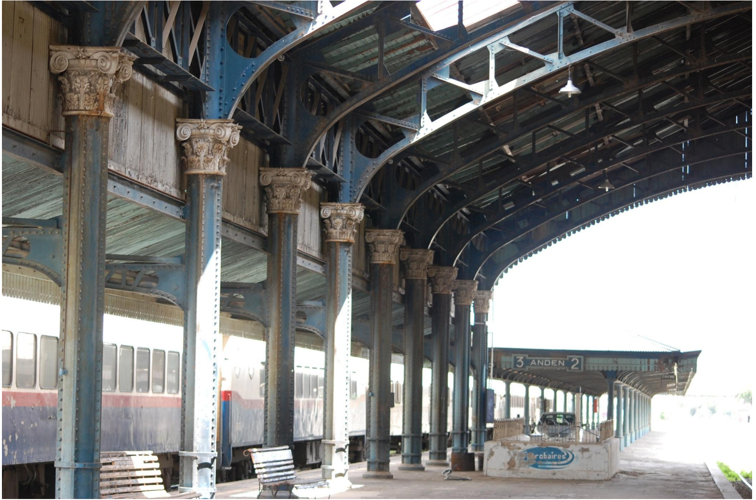
Estación Ferrocarril del Sud. Detalle de las columnas de hierro fundido con capiteles corintios
