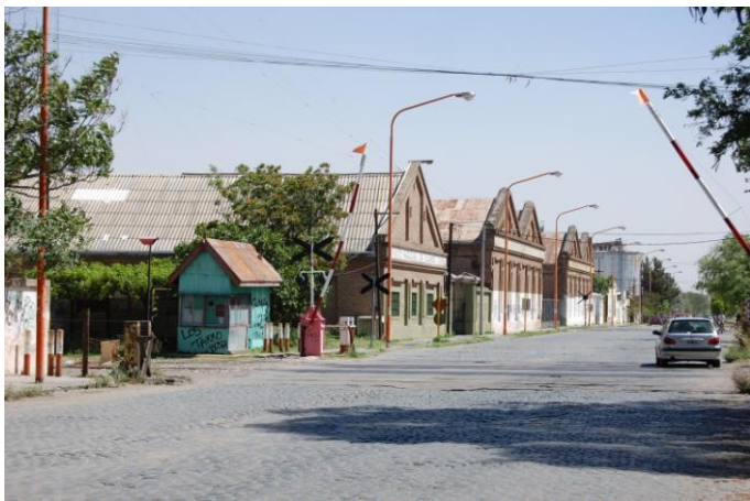
Mercado Victoria. Vista desde calle Undiano de las etapas construidas por la empresa BAP.
