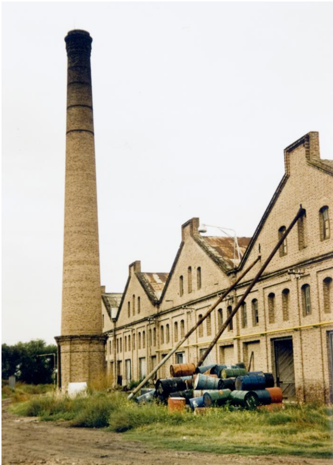
La Lanera Argentina. Vista posterior del edificio; se puede apreciar las características típicas de los edificios industriales de esta época, con sus paredes de ladrillo, sus grandes naves, la resolución morfológica de sus techos y la infaltable chimenea.
