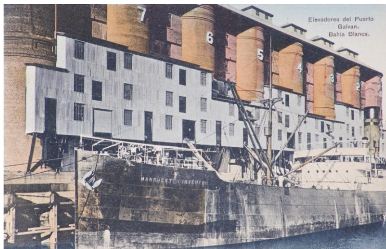
Puerto Galván. Vista del Elevador n°1.
