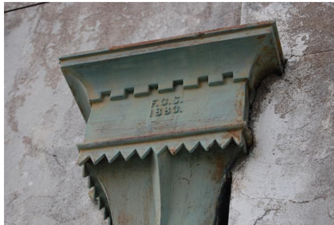
Detalle de los desagües pluviales realizados en hierro fundido.
