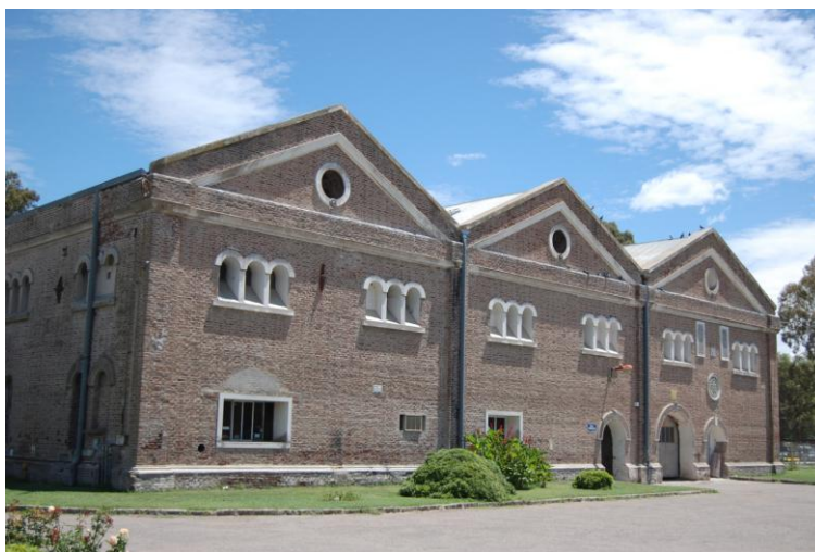
Villa Rosas. Compañía de Gas. Vista actual de los pabellones.
