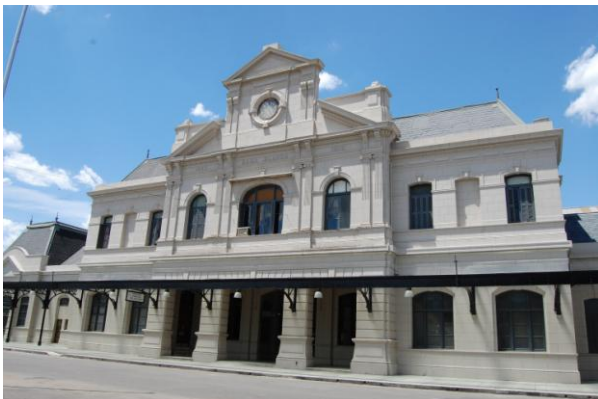
Vista actual de la Estación Ferrocarril del Sud (1910).
