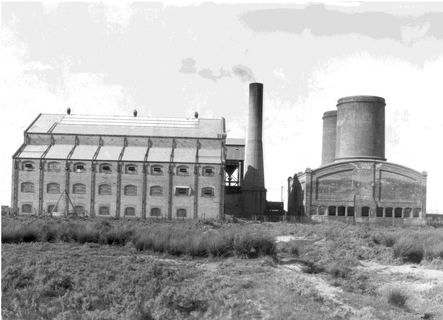
Usina del ferrocarril Buenos Aires al Pacifico en Loma Paraguaya (1910). Constituyó una de las mejores obras construidas en nuestro medio. Lamentablemente la mayor parte del conjunto ha sido demolida.
