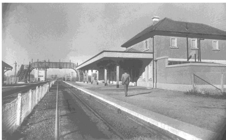
Vista del andén de la estación en funcionamiento.
